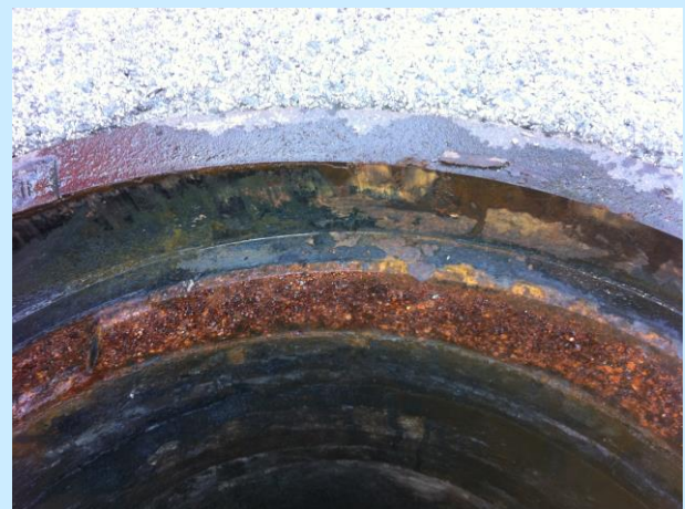
Schachtdeckel und Armaturen von Rost befreit, ...
