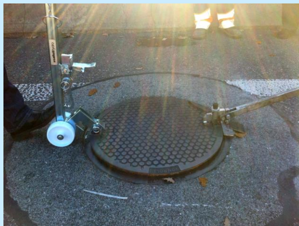
Verrostete und eingeklemmte Schachtdeckel werden mit einer Zugmaschine geöffnet, ...
