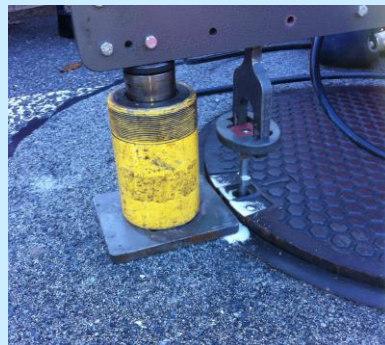
Verrostete und eingeklemmte Schachtdeckel werden mit einer Zugmaschine geöffnet, ...
