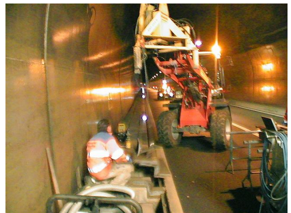
Schachtdeckel ausheben, ...
