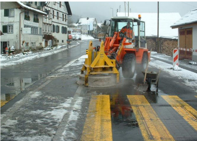
Schneiden von Bund- oder Wasserstein
